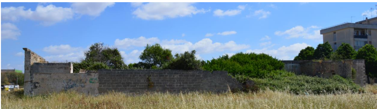
Figura 4-62. Vegetazione cresciuta all'interno del rudere.
